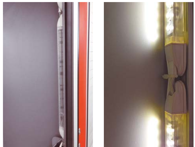
LED-Beleuchtung an den seitlichen Laufschiene montiert
